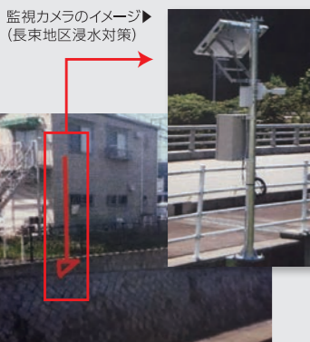
監視カメラを設置する新安川の新声田屋橋(長束地区浸水対策)
